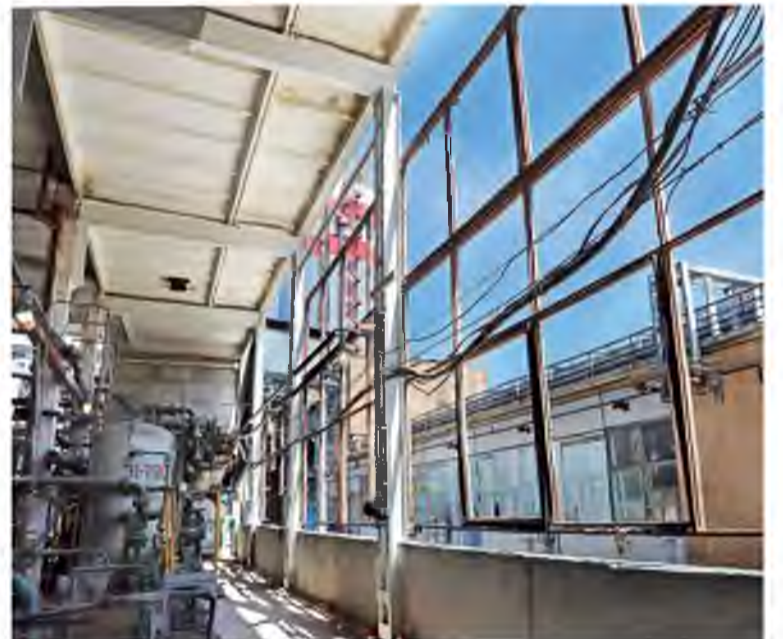
В корпусе №507 идёт замена фасада
